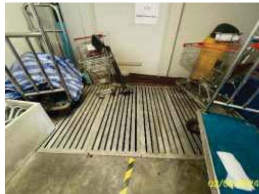
ท่อพักน้ำก่อนปล่อยออกนอกโครงการ
